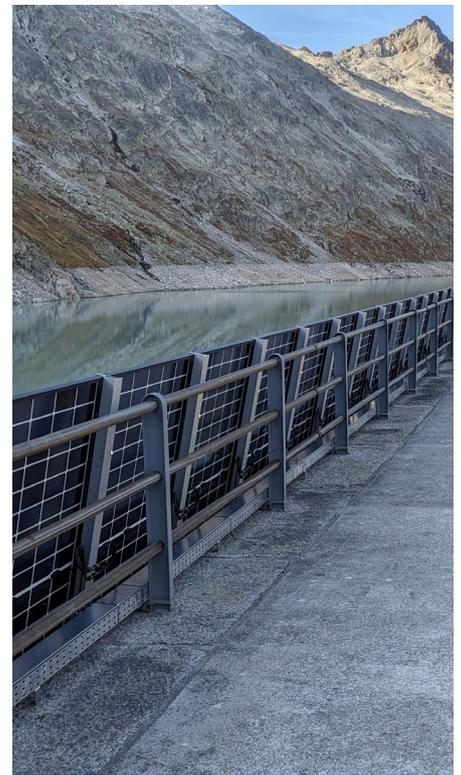
(Oberland bernois), à environ 1800 m et 2300 m au-dessus du niveau de la mer. Les modules bifaciaux absorbent la lumière du soleil sur les faces avant et arrière et la convertissent en énergie. L'ensemble de ces installations photovoltaïques alpines couvre une surface d'environ 3 000 m<sup>2</sup> et génère une puissance totale d'environ 550 kWp (puissance maximale).
